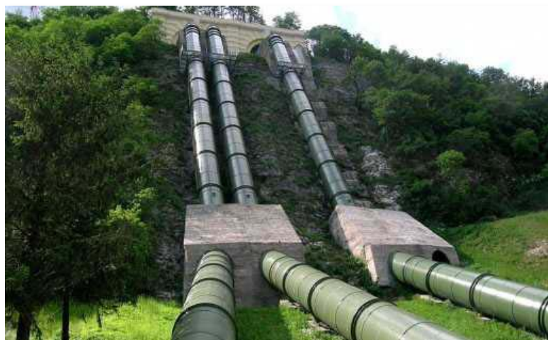
Centrale idroelettrica di Vittorio Veneto (TV)
