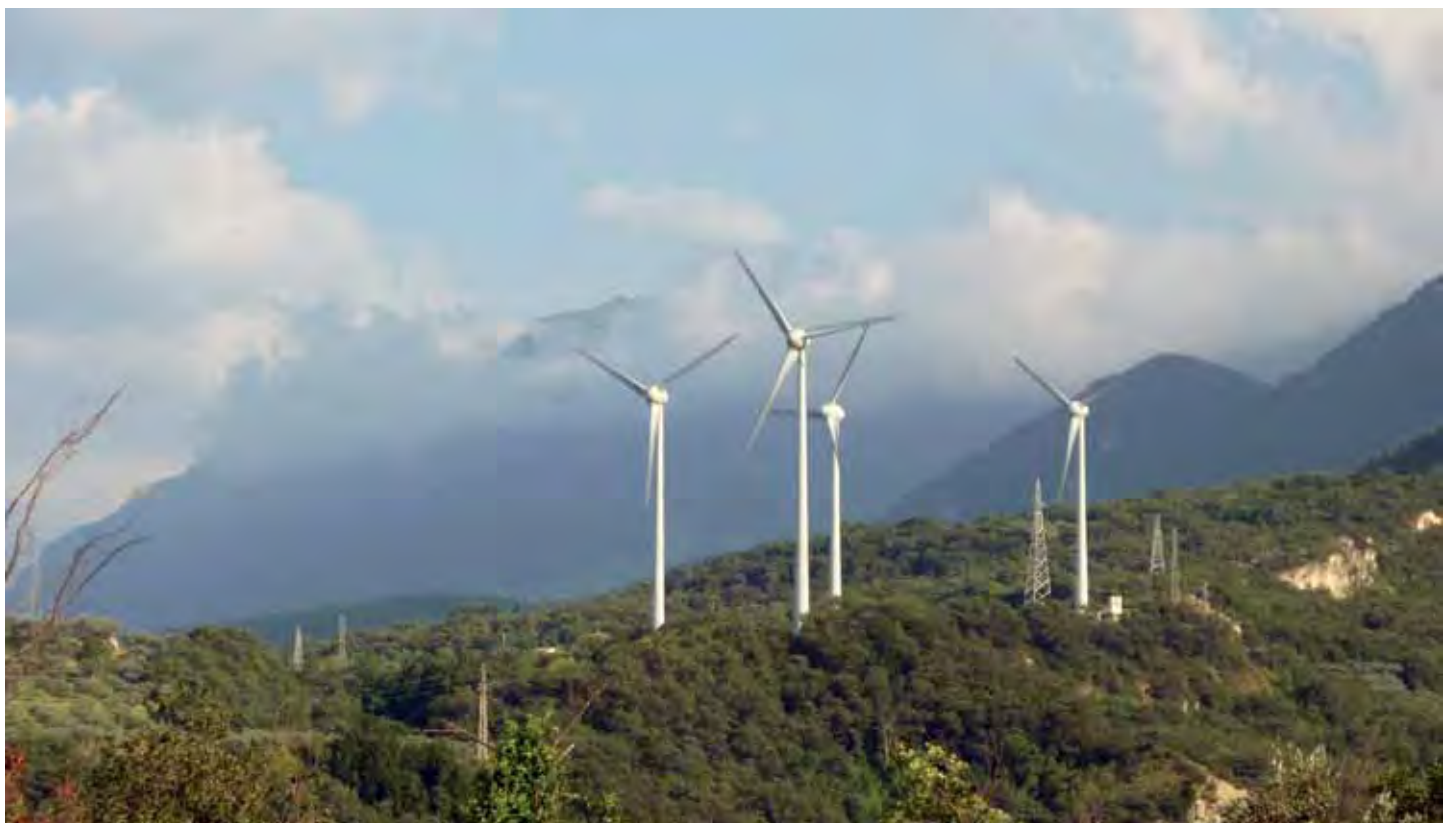
Il parco eolico di Tocco da Casauria (PE)
