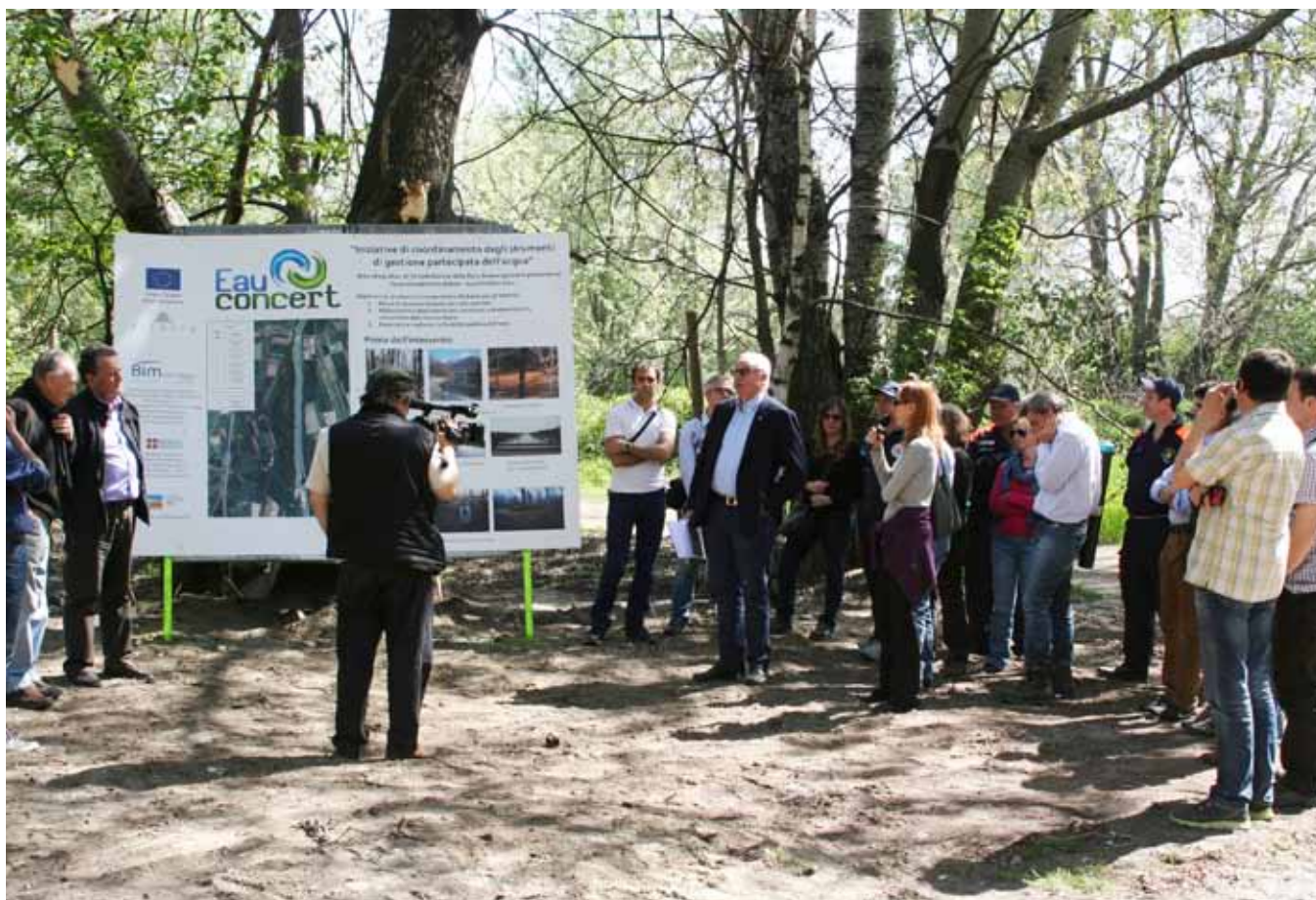
Visita al cantiere pilota con i partner francesi
