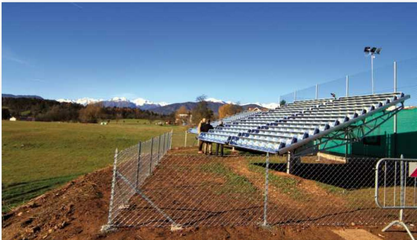
*Il sistema fotovoltaico a concentrazione Archimede*
