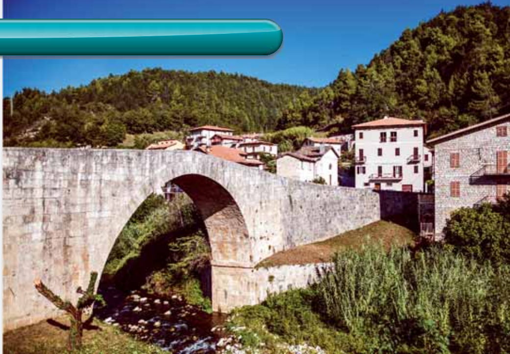
Veduta del Ponte Romano ad Acquasanta (AP)
